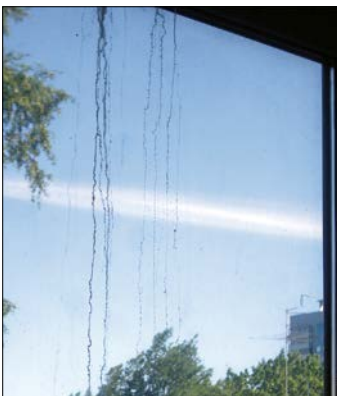
Неудаленные вовремя потеки раствора строительной или отделочной смеси вызывают необратимые изменения поверхности стекла.
