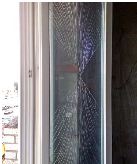
«Песочные часы» — с таким узором происходит разрушение стеклопакетов при перепадах давления или температуры, в том числе и в горной местности.
