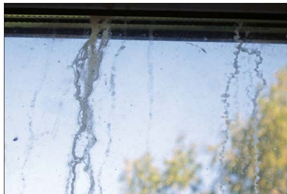
Неудаленные вовремя потеки раствора строительной или отделочной смеси вызывают необратимые изменения поверхности стекла.
