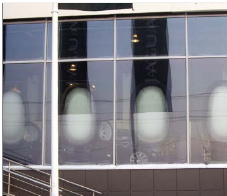
Еще одна проблема из-за упущения при выборе стеклопакета: слипание и смерзание стекла изнутри.
